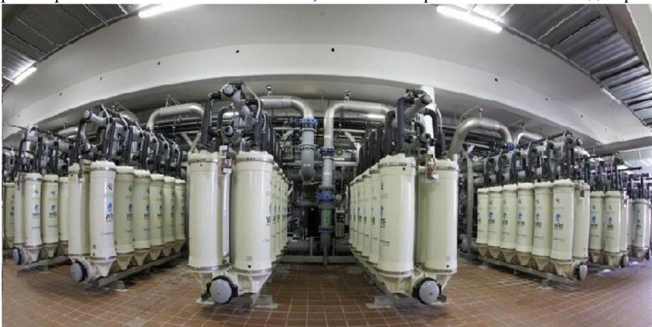
**Рис.6.** Блоки ультрафильтрации на Юго– Западной водопроводной станции Москвы (источник <http://www.uz-vs.ru/?file=kop2.php>)
